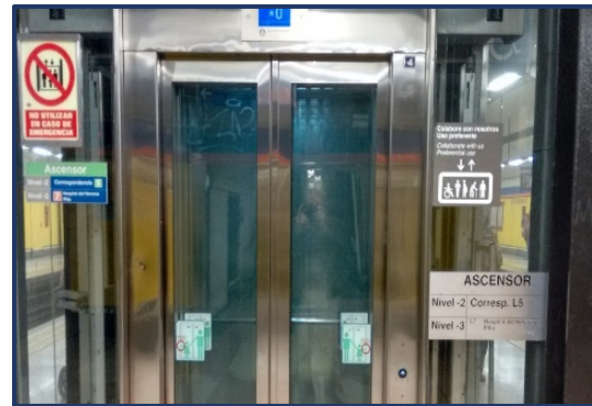
Señalización exterior del ascensor A4 a nivel del andén de la línea 7
