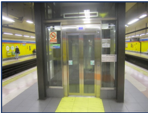
Ascensor A4 a nivel del andén de la línea 7
