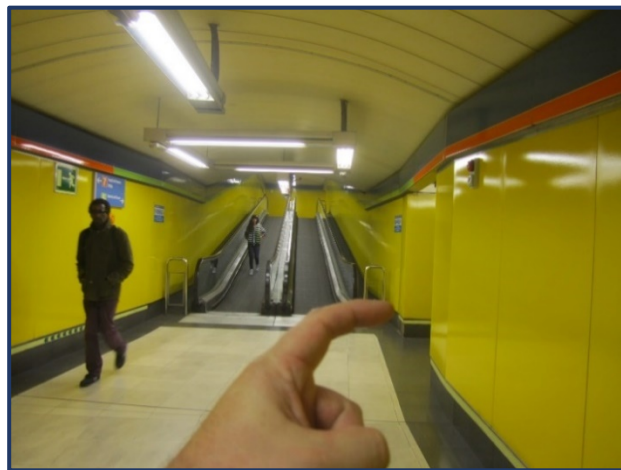
Hueco en el que se localiza el ascensor A2
