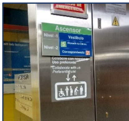
Señal exterior del ascensor A2
